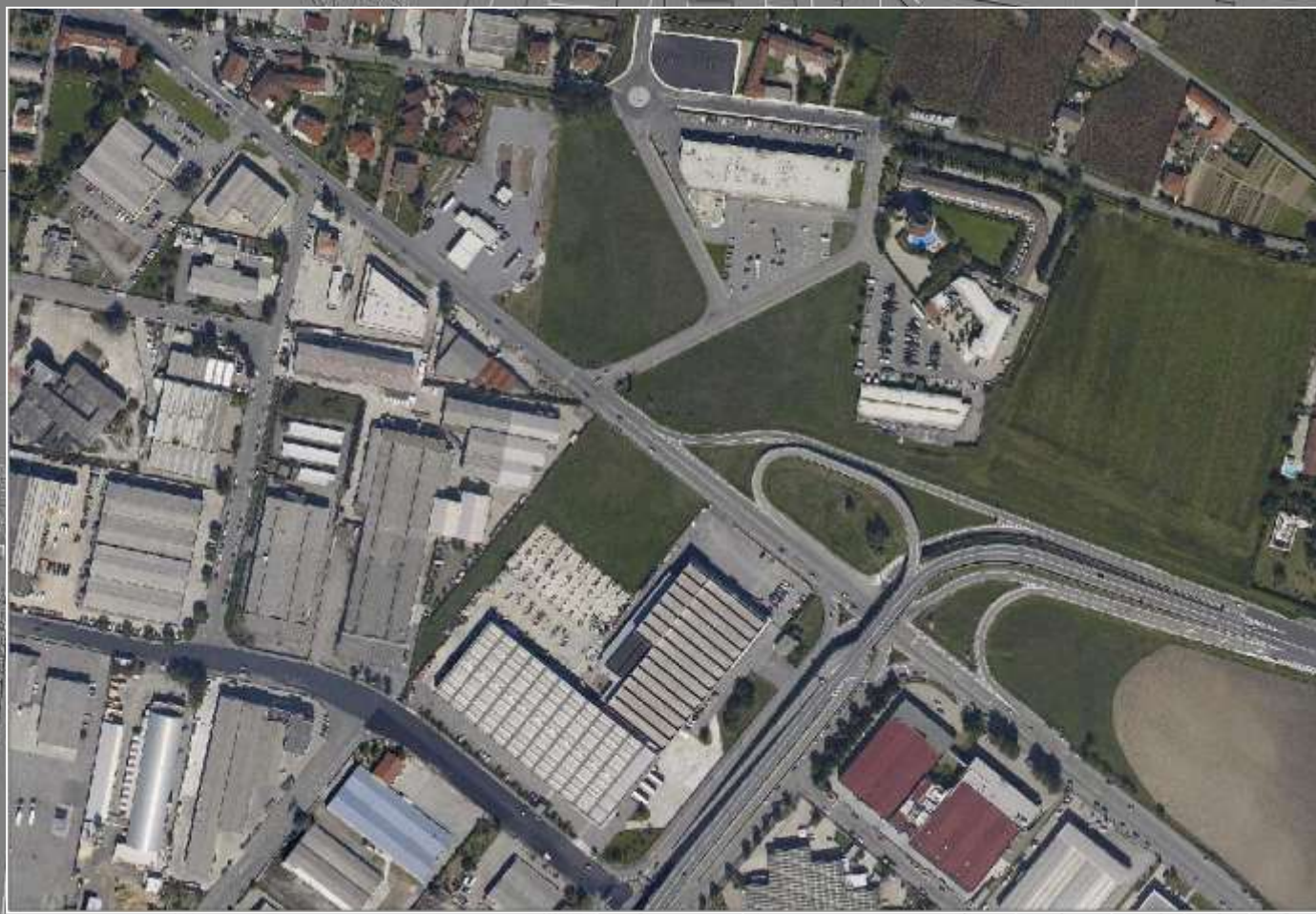
Svincolo A26 in Strada Valenza
