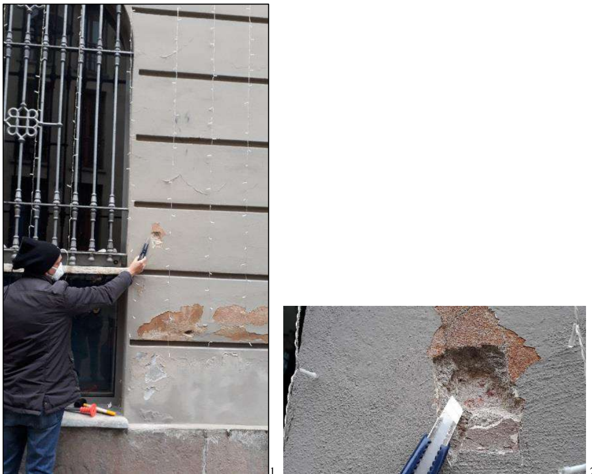
Figura 23 – Dalle immagini dell’edificio (1) e del punto di campionamento (2) si vede chiaramente come si siano susseguite colorazioni differenti nel tempo (Foto Boero).
