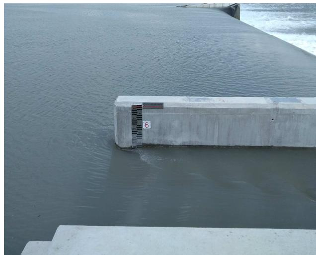
**Fig.9 – Fotografie aste idrometriche in sx e dx**
